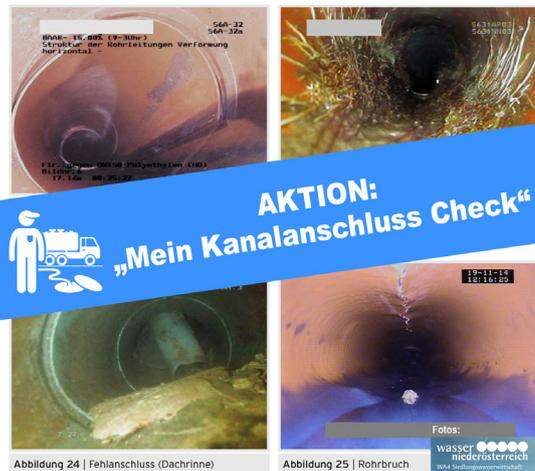
Im Rahmen der derzeit laufenden Hochwassersanierungen wird unser über 43 km langes öffentliches Kanalsystem gereinigt und mit Video-Kameras befahren. Ziel ist es, die Schäden zu ermitteln und in der Folge zu beheben.
